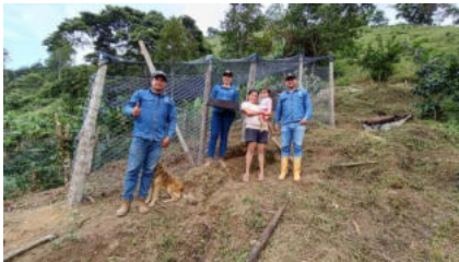
Construcción De Huerta Casera S -Vereda La Meseta
